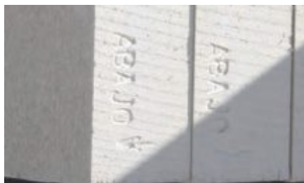
Fig. 4: Identificar lado que va hacia abajo.
