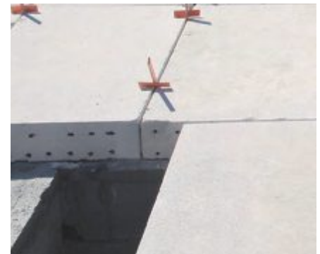
Fig. 6: Separación de la Junta.
