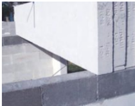
Fig. 5: Colocación de paquetes sobre muros cargadores.
